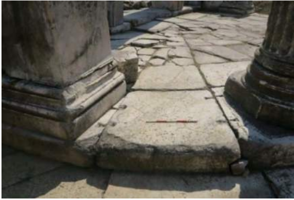
Figür 12: Görülebilir Şekilde Yapılan Kırlangıç Kuyruğu Kenet Yuvaları (Dekoratif Kenetler)
