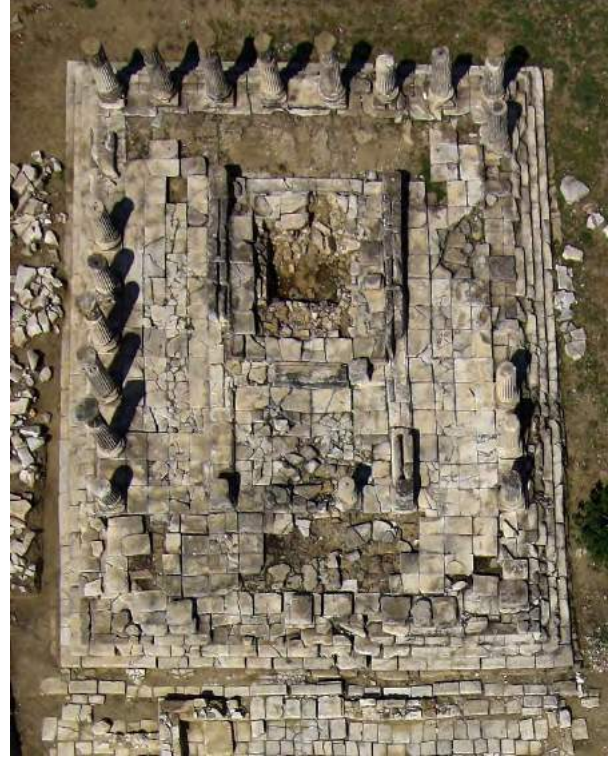
Figür 3: Hekate Tapınağı'nın mevcut durumu
