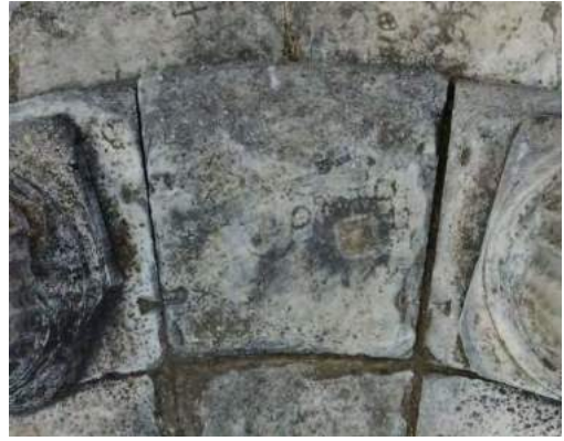
Figür 13: Görülebilir Şekilde Yapılan Kırlangıç Kuyruğu Kenet Yuvaları (Dekoratif Kenetler)
