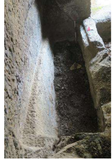
Figür 34: Teknenin üst yüzeyindeki kapak taşının oturacağı profiller
