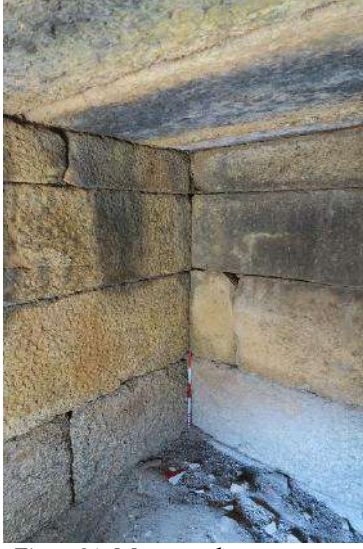
Figür 21: Mezarın duvar örgüsü
